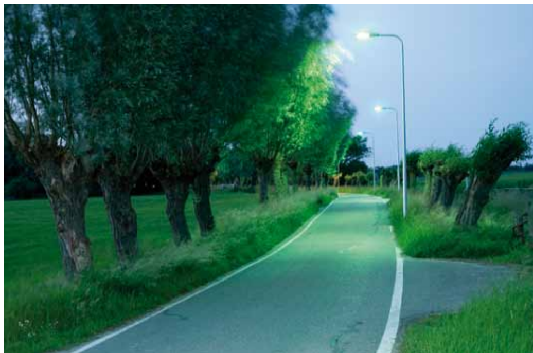
Greene led-verlichting past goed bij het landschap en verbruikt tweemaal zo weinig energie als witte led-verlichting.
